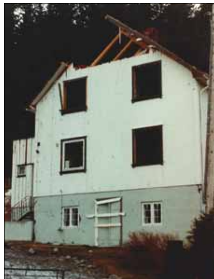
Skadet Bolighus ved rørgata. Foto NVE
