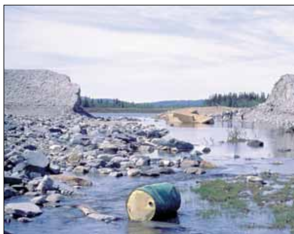
Dambrudd Roppa. Foto: NVE
